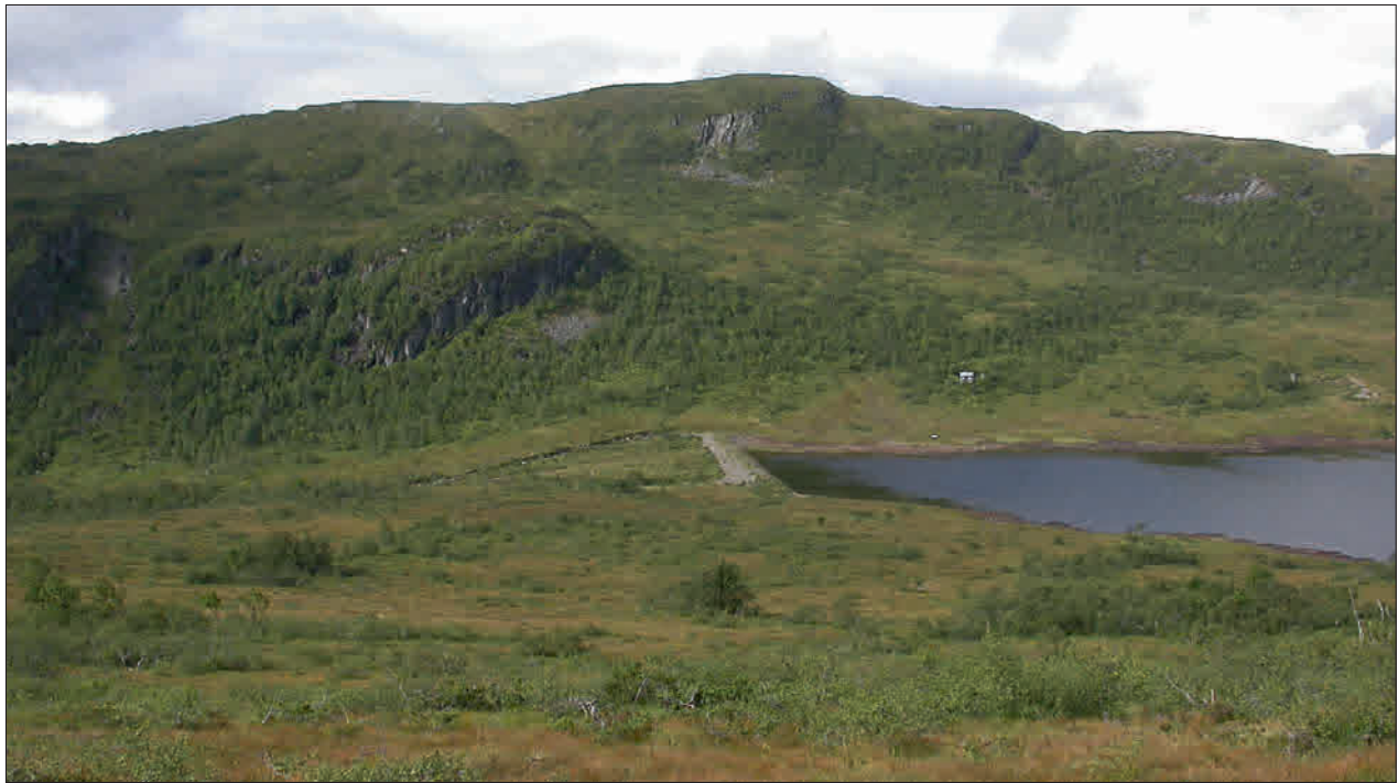
Vasslivatnet i Mjelvedalen. Gullberghammaren bak demninga. 2010. (Foto KMH/Romsdalsmuseets fotoarkiv 314583)
