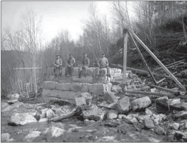
Frå bygginga av Bordalsbrua 1928. Vegen rundt Osen vart ferdig 1930. (Foto Thomas T. Ulleland/Romsdalsmuseets fotoarkiv 26120)
