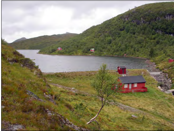
Sørenden av Kloppavatnet med demninga. (Foto KMH/Romsdalsmuseets fotoarkiv 31474)
