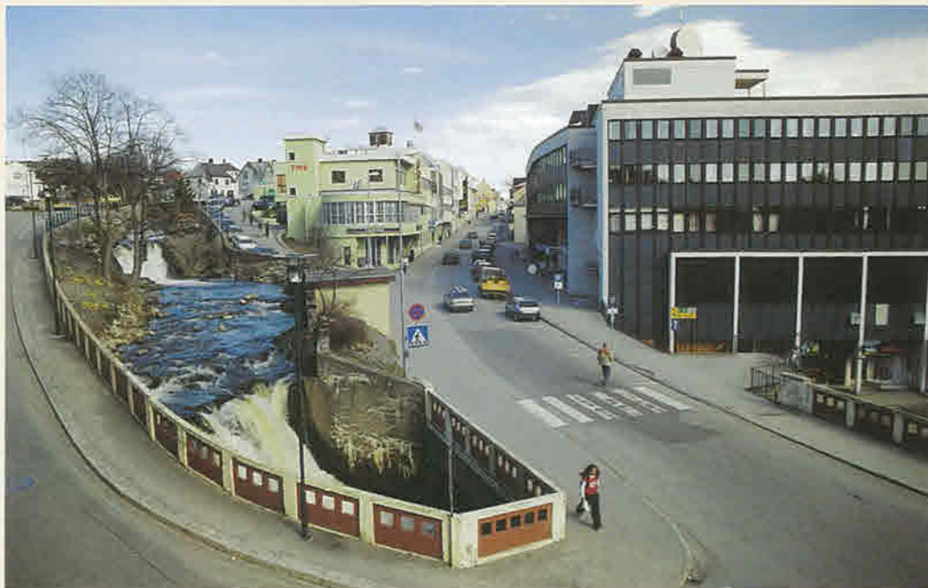
Romsdalsgata mot øst med Fossbrua og forstøtningsmurene langs elva fra 1920-årene.
