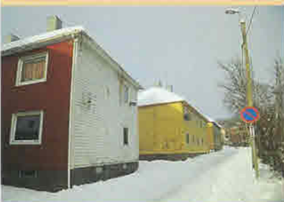
Bolighusene i «Mexico» rehabiliteres og moderniseres.
